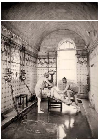
Annexe Revel. Cabine de douches, 1904. AC Aix-les-Bains
